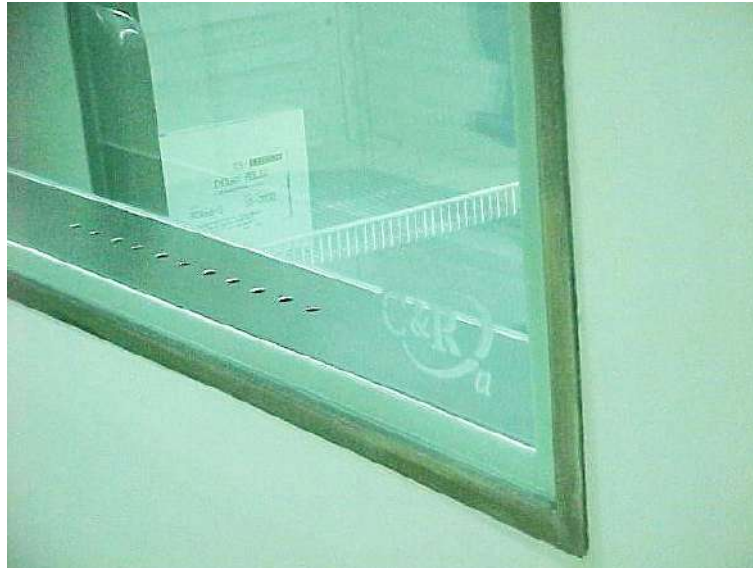
Figura 4 - Ventana con marco metálico y sistema para evitar condensaciones
