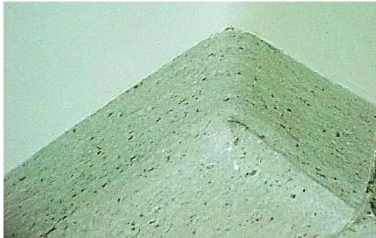
Figura 1 - Piso con zócalo sanitario
