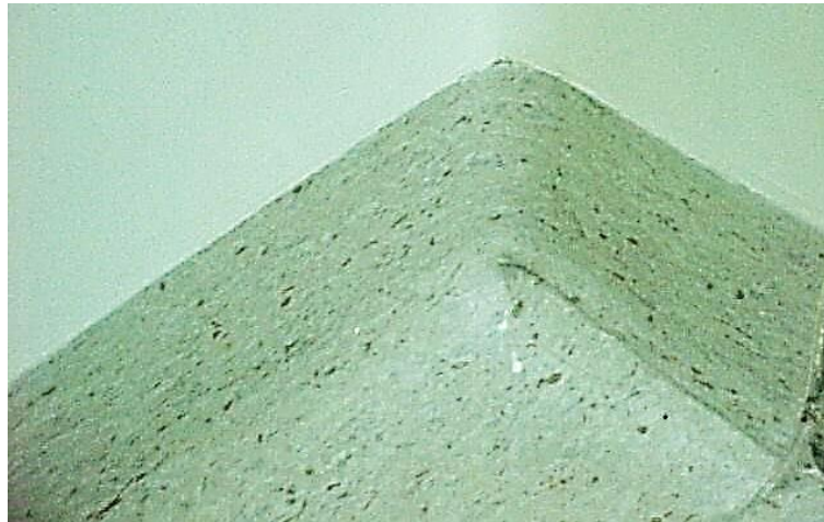
Figura 1 - Piso con zócalo sanitario
